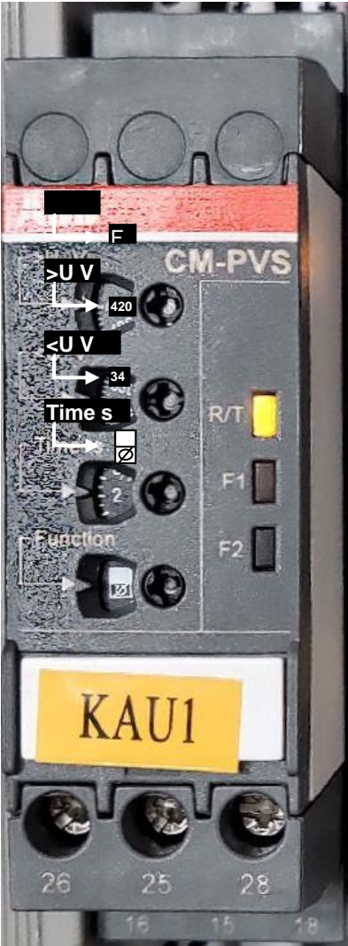
图 8-22 主控柜电压监视继电器设置值检查
