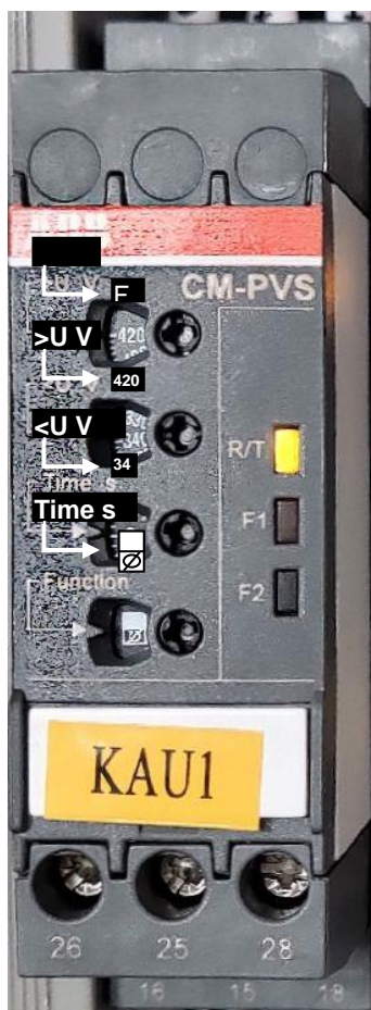
图 8-40 主控柜电压监视继电器设置值检查
